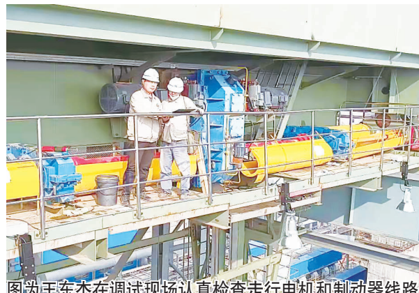
图为王东杰在调试现场认真检查走行电机和制动器线路
